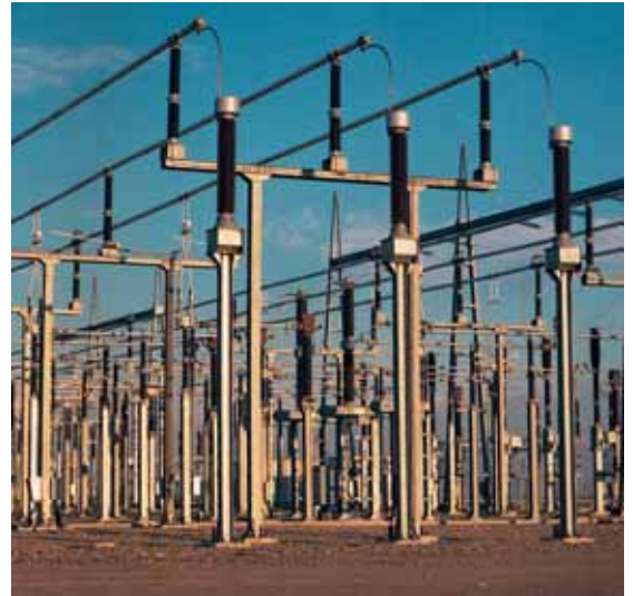
245 kV Inductive Voltage Transformers Red Eléctrica Española (Spain)
