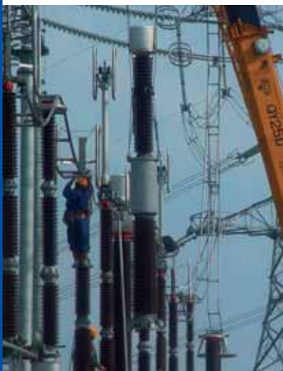
Instalación de Transformadores de Tensión Inductivos de 525 kV para Siemens-Alemania en China.
