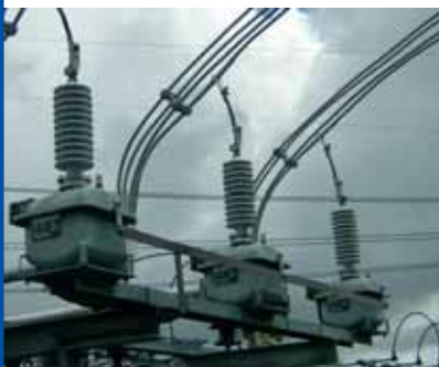
Transformadores de Tensión Inductivos de 36 kV. Transpower (Nueva Zelanda).
