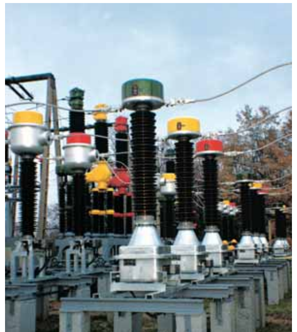
Tranformadores de Tensión Inductivos de 123 kV. MVM (Hungria).
