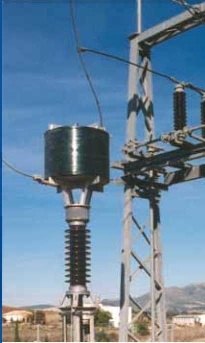
Bobina de Bloqueo de ARTECHE montada en pedestal sobre Condensador de Acoplamiento ARTECHE line trap mounted on top of a coupling capacitor (pedestal mounting)
