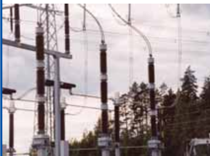
Transformadores de Tensión Capacitivos de 420 kV instalados en Finlandia con rango de temperatura -50° a +40° C 420 kV Capacitive Voltage Transformers installed in Finland for temperature ranges of between -50° and +40° C
